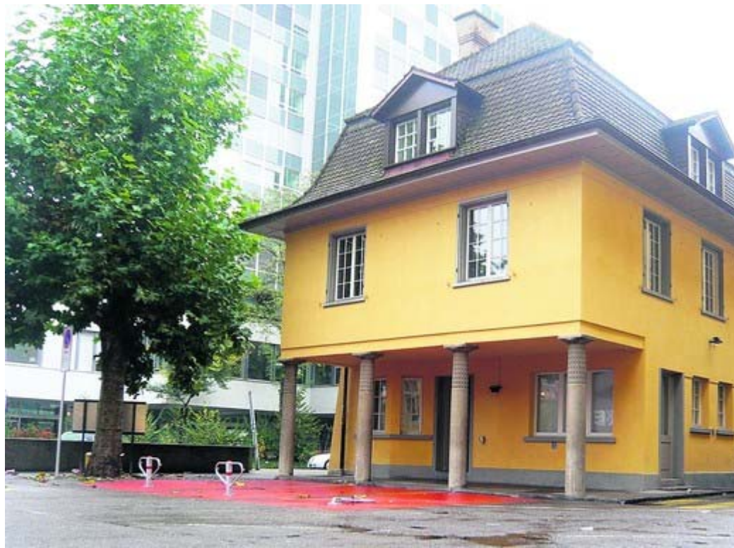
Das Pförtnerhaus an der Bruggerstrasse 37a, beim Merker-Areal, wird vom 19. bis zum 23. Dezember zum Weihnachtskiosk. (Foto: Zora Schiess) Quelle: SAB
